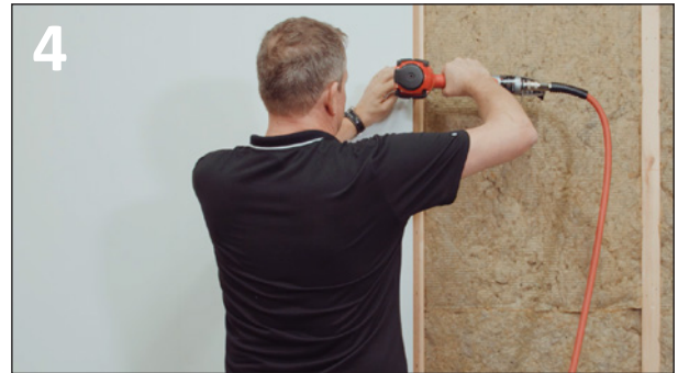
4 START MONTERING FRA VENSTRE MOT HØYRE. HUSK KUBBING I HJØRNER SAMT VED DØR/VINDU.
