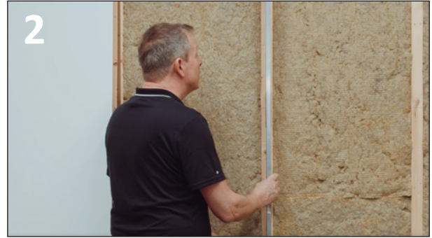
2 SJEKK AT VEGGEN ER HELT RETTE FØR MONTERING.
