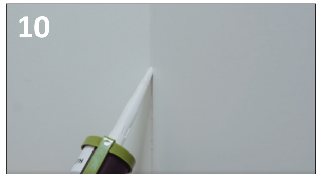
10 HUNTONIT AKRYLMASSE ANBEFALES TIL INNVEDIGE HJØRNER.
