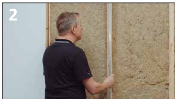
2 SJEKK AT VEGGEN ER HELT RETTE FØR MONTERING
