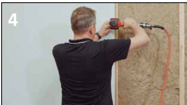
4 START MONTERING FRA VENSTRE MOT HØYRE. HUSK KUBBING I HJØRNER SAMT VED DØR/VINDU
