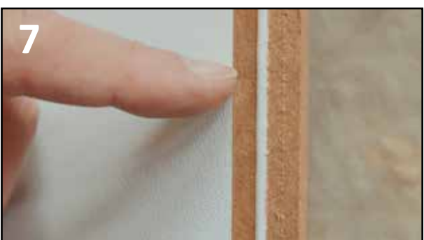
7 CA 1MM TYKK LIMSTRENG VINTERLIM NEDE I PROFILEN
