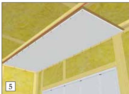
5) 1. platerad monteres etter snor. Spikeravstand er c/c 150 mm. NB: platene monteres 10mm fra alle vegger.
