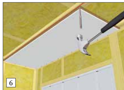
6) For å unngå skader på platen utføres siste spikerslag med dor. Kramper og skruer kan også benyttes på platen.
